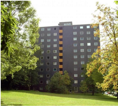
Außenansicht des Wohnheims
